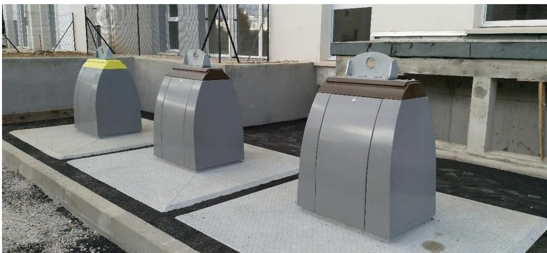
Figure 5 : bornes enterrées à Angerville
